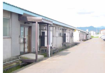
米沢営業所・米沢サイト 新進テック株式会社 米沢事業所
