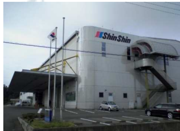
掛川センター・掛川プリンティングセンター
